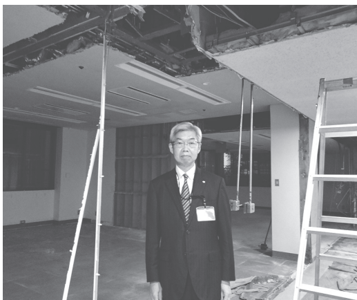
改修工事中の現場にて
